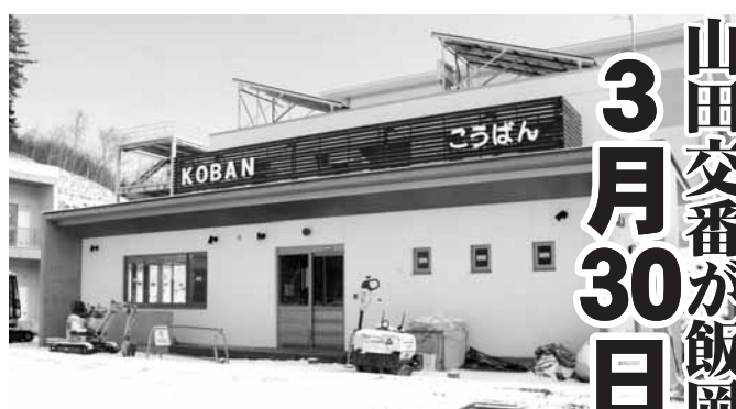
新設中の山田交番
