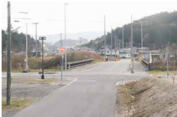
Cさんが自宅に向かうために渡った北っ子橋。渡って間もなく、橋が架かる関口川では津波が逆流し、あふれ出した
