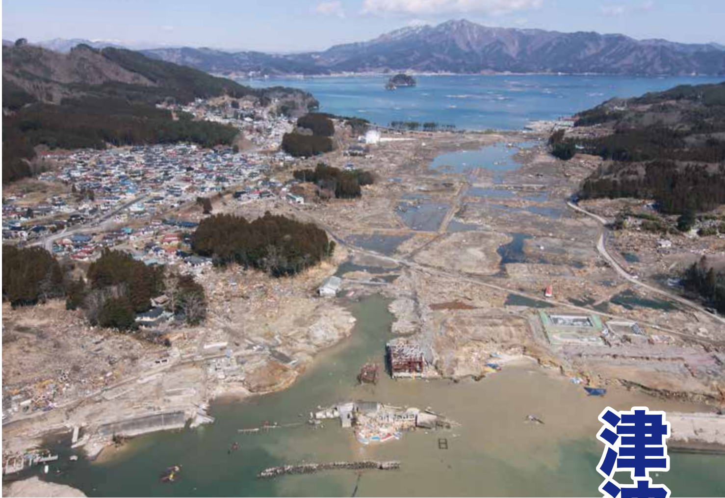
大津波が船越地峡（船越半島の付け根）を南側の船越湾（手前）から北側の山田湾（奥）に向かって越流し、防潮堤や建物の破壊・流失、侵食による海岸線の変化などの痕跡を残した（平成 23 年 3 月 28 日午前 10 時 19 分撮影）
