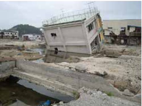
図2-26 戻り流れによる地盤の侵食で一部陥没・不等沈下したとみられる建築物
