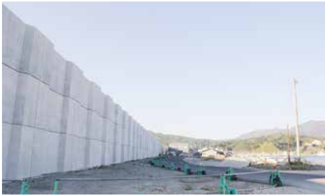
山田漁港を囲む海抜 9.7 メートルの新しい防潮堤。ハード面の整備とともに、避難対策を確固としたものにすることが重要だ
