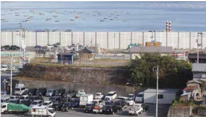
町指定の避難場所の一つで中心街にある「御蔵山」。石垣に囲まれた標高約10mのこの高台には、3・11 大津波で多くの人が逃げ込み、助かった
