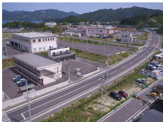
写真 公共防災拠点
